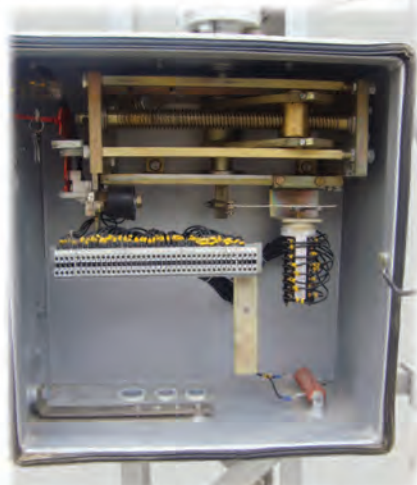
مکانیزم فرمان دستی نوع ( RTP-1 ) Manual Drive Type ( RTP-1 )
